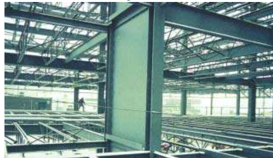
SPSW dengan konfigurasi planar systems Canam HQ, US (Ignasius and John, 2005)
