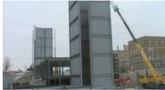
SPSW dengan konfigurasi core systems , Montreal, Canada (Ignasius and John, 2005)
