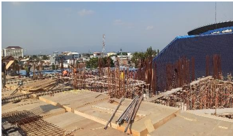
Gambar 15. Pekerjaan Pemasangan Bekisting
