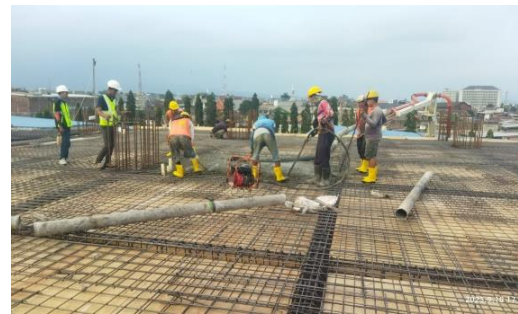
Gambar 20. Pekerjaan pengecoran plat lantai
