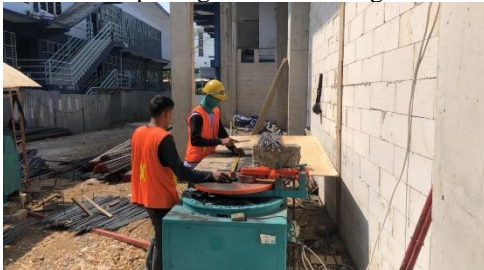
Gambar 16. Pekerjaan fabrikasi tulangan
