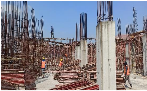
Gambar 14. Pemasangan perancah
