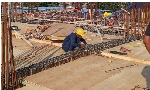
Gambar 17. Pekerjaan pembesian balok
