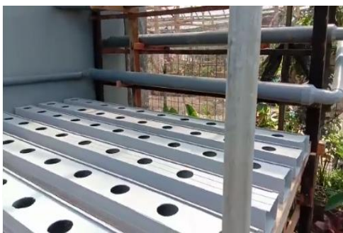
Gambar 6. Pemasangan pipa paralon untuk sirkulasi cairan nutrisi
