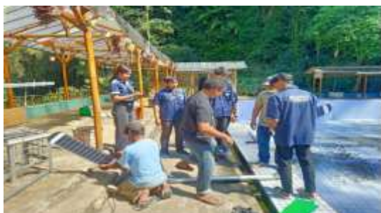
Gambar 5 Proses pemasangan PLTS
