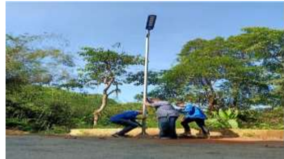
Gambar 6 Proses pemasangan PLTS
