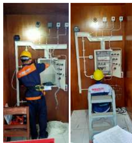
Gambar 8. Pemasangan Panel, Pengawatan & Pengecekan Instalasi
