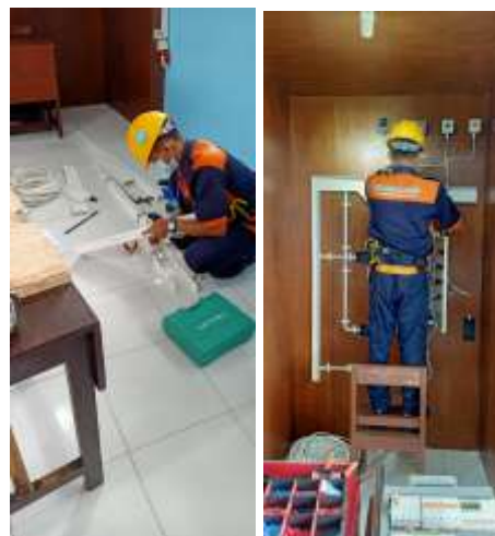
Gambar 7. Perakitan & Pemasangan Jalur Kabel
