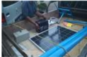
Gambar 7. Pemasangan &amp; Pengawatan Panel Surya
