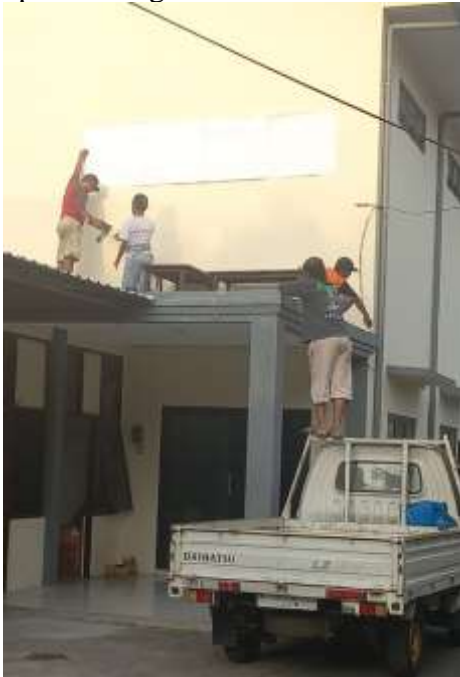
Gambar 7. Pemasangan banner sebagai panduan kedudukan tempat huruf agar jarak antar hurufnya mengikuti standar spasi antar huruf sesuai dengan standar pada komputer
