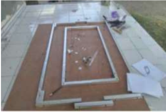
Gambar 9. Pembuatan Cetakan Precast Boks Bagi
