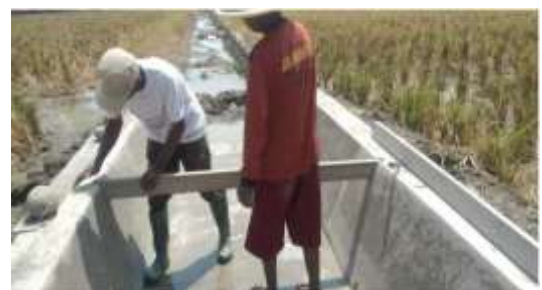
Gambar 8. Pemasangan Balok Penyangga
