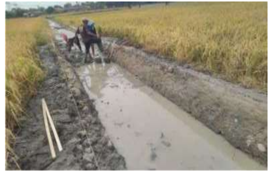
Gambar 5. Pekerjaan Lining Saluran
