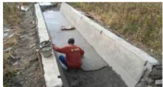
Gambar 7. Pekerjaan Mortar Ferosemen
