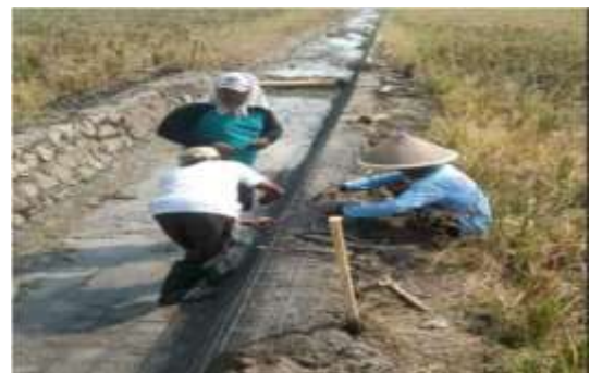
Gambar 6. Pekerjaan Penulangan Saluran
