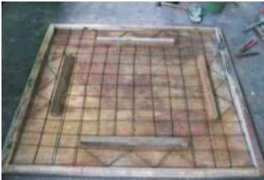
Gambar 10. Pekerjaan Penulangan Boks Bagi
