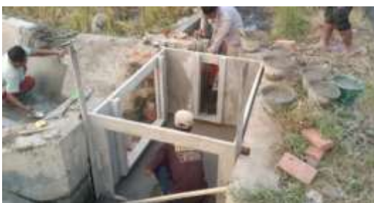
Gambar 12. Instalasi Precast boks bagi
