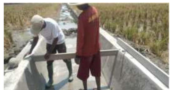
Gambar 8. Pemasangan Balok Penyangga
