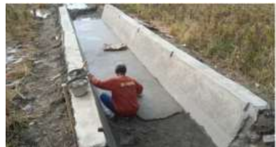
Gambar 7. Pekerjaan Mortar Ferosemen
