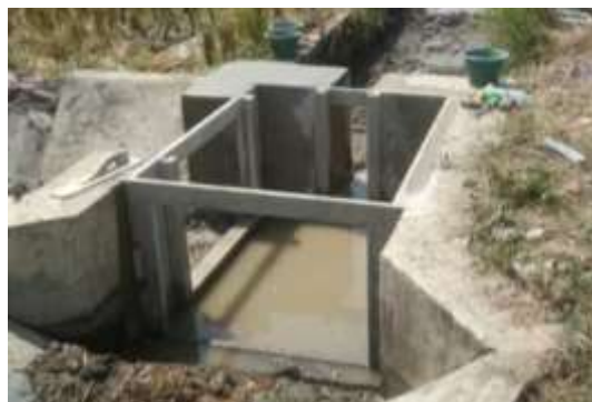
Gambar 14. Percontohan dan Boks Bagi Dengan Beton Ferosemen
