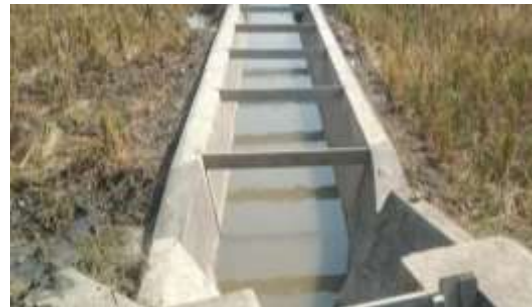
Gambar 13. Percontohan Saluran Irigasi Dengan Beton Ferosemen
