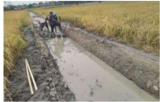
Gambar 5. Pekerjaan Lining Saluran
