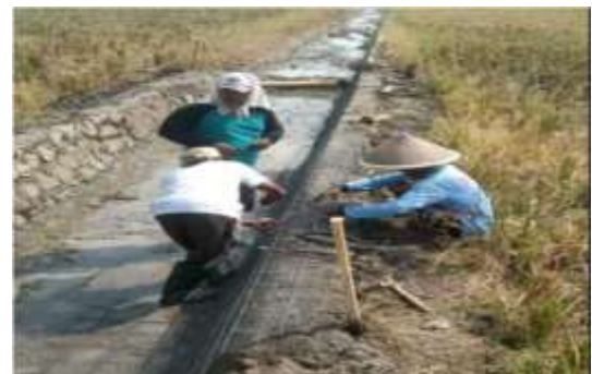
Gambar 6. Pekerjaan Penulangan Saluran
