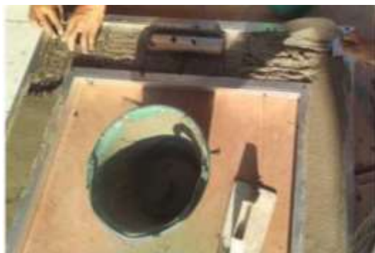
Gambar 11. Perkerjaan Mortar Ferosemen
