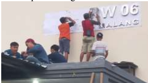
Gambar 8. Pemasangan banner dan pelubangan dengan pengirisan memakai cutter sebagai kedudukan tempat huruf agar jarak antar hurufnya mengikuti standar spasi antar huruf sesuai dengan standar pada komputer
