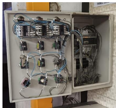
Gambar 11: Rangkaian heater automatic run sudah selesai di pasang dan di test siap digunakan, tampak dalam
