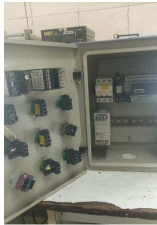
Gambar 10: Instalasi angkaian heater automatic run dalam box
