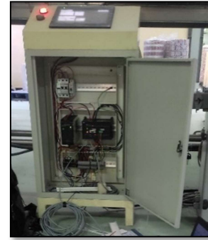
GAMBAR 3.8 HASIL PEMASANGAN DALAM PANEL
