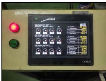
GAMBAR 3.7 PEMASANGAN PANEL HMI
