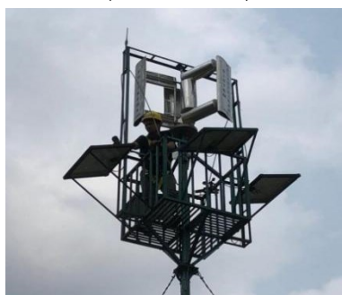
Gambar 3.2. Pemasangan Panel Surya Baru
