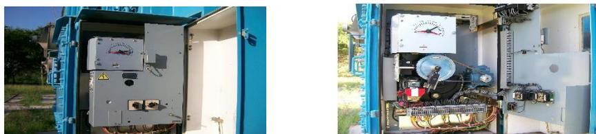
Gambar 3.5. Panel transformator dan komponen OLTC
