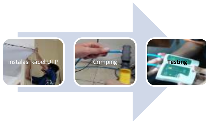
Gambar 3. Proses Instalasi Kabel UTP pada Salah Satu Kantor Kelurahan
