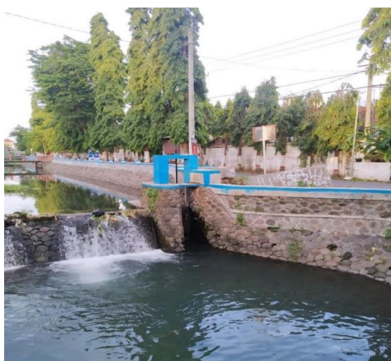
Gambar 2. Pintu Air Tampak Samping Kiri
