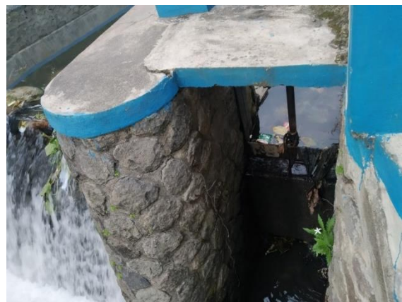
Gambar 3. Pintu Air Kecil Tampak Depan
