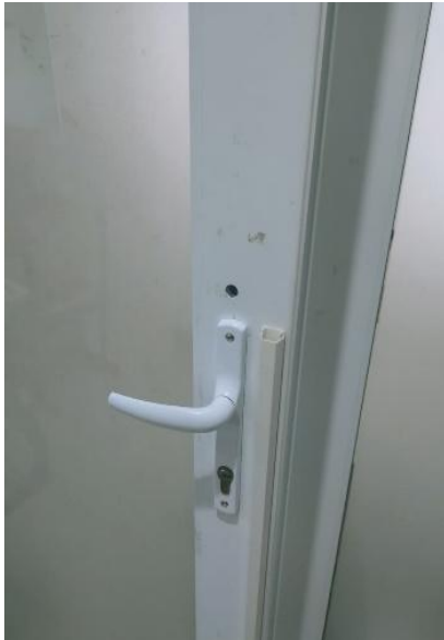
Gambar 8. Pintu Sebelum Dipasang Alat
