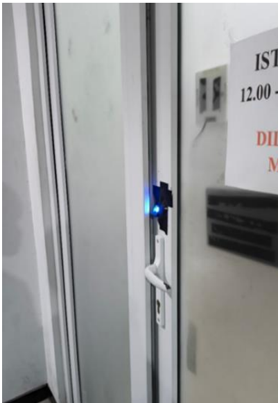
Gambar 9. Pintu Setelah Dipasang Alat
