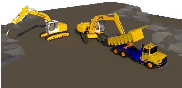
Gambar 6. Menggunakan Hydraulic Breaker untuk pekerjaan galian Sumber: Hasil Analisis, 2022
