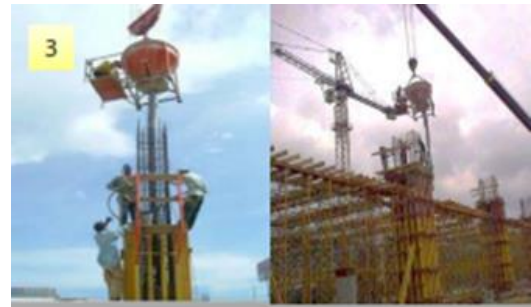
Gambar 9. Pengecoran Kolom
