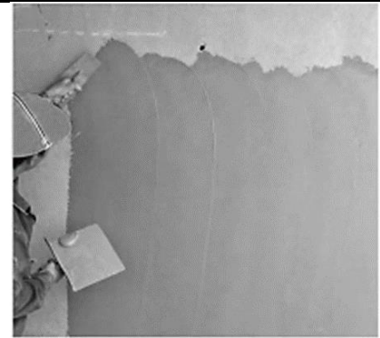
Gambar 11. Pekerjaan Acian
