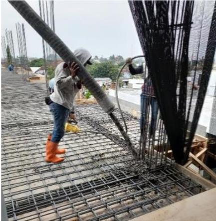
Gambar 3. 14 Pekerjaan Pengecoran Kolom
