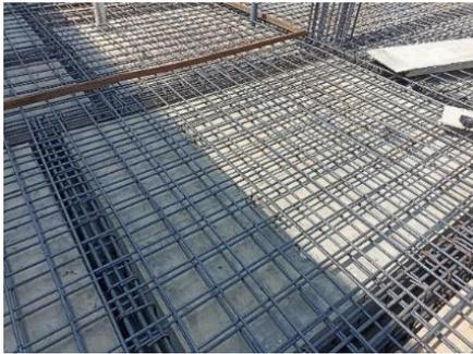
Gambar 3. 32 Hasil Pekerjaan Pembesian Plat Lantai
