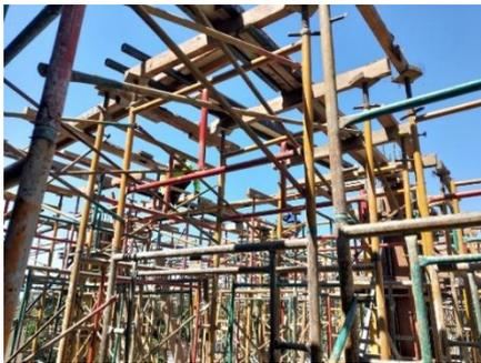
Gambar 3. 17 Pemasangan Bekisting Balok
