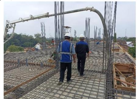
Gambar 3. 28 Pekerjaan Pengecoran Balok
