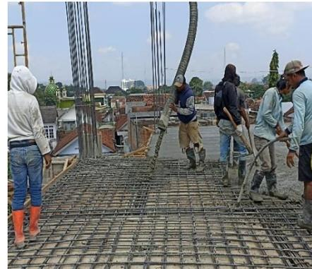
Gambar 3. 33 Pekerjaan Pengecoran Plat Lantai
