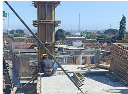
Gambar 3. 12 Pemasangan Bekisting Kolom
