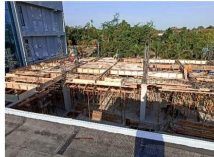
Gambar 3. 30 Pekerjaan Bekisting Plat Lantai
