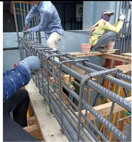
Gambar 3. 27 Pekerjaan Pembesian Balok
