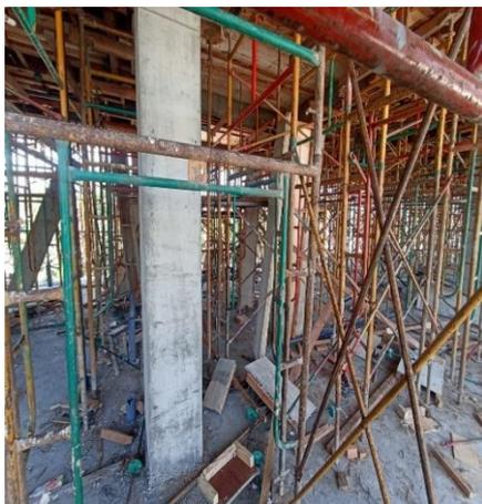
Gambar 3. 15 Kenampakan Kolom setelah Pembongkaran Bekisting
