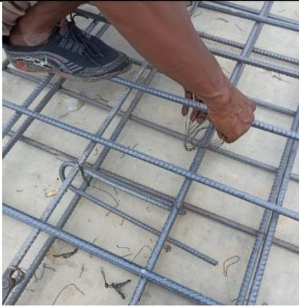
Gambar 3. 81 Pekerjaan Pembesian Plat Lantai
