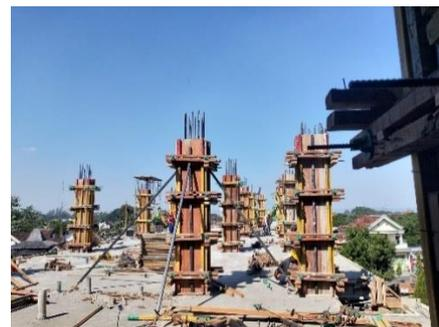
Gambar 3. 13 Hasil Pekerjaan Bekisting Kolom
