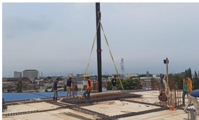
Gambar 4. Pengangkatan Wiremesh
