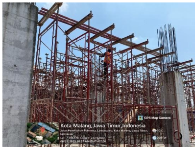
Gambar 5. Pemasangan Scaffolding
