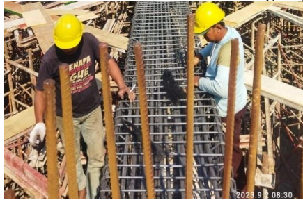
Gambar 3. Pemasangan Sengkang Balok
