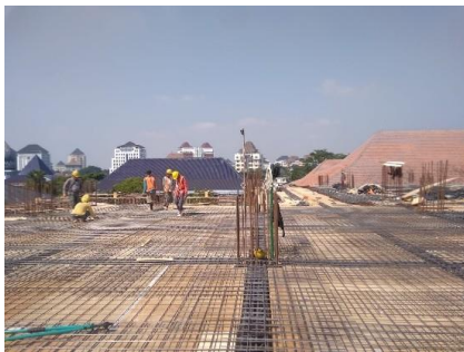
Gambar 4. Pemasangan Wiremesh
