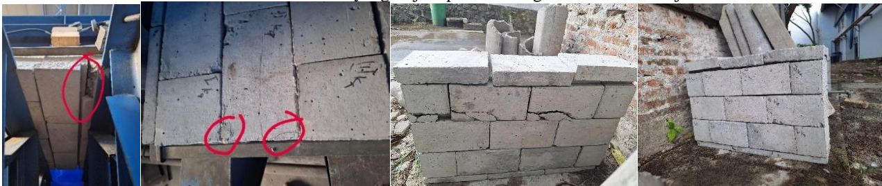
Gambar 8 Deformasi yang terjadi pada dinding interlock benda uji 2
