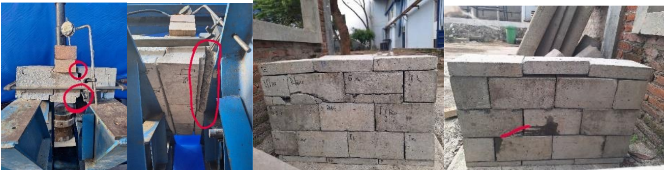
Gambar 7 Deformasi yang terjadi pada dinding interlock benda uji 1
