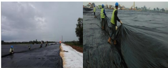
Gambar 10. Pemasangan Geomembran
