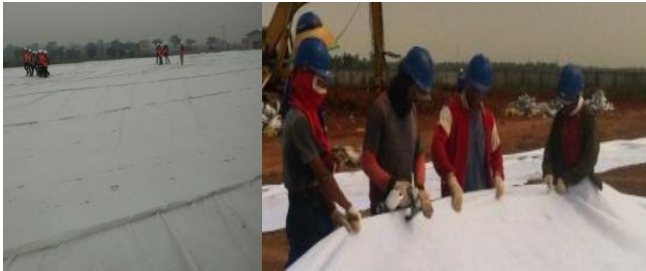
Gambar 9. Pemasangan Geotekstil Non-Woven
