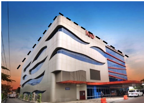
Gambar 2. Eksisting Gedung yang Ditinjau
