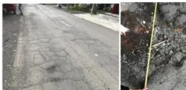
Gambar 3 Dokumentasi Survey Kerusakan Jalan
