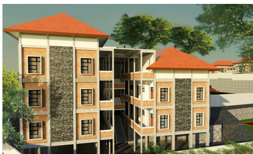
Gambar 7 Modelling 3D Tampak Utara Bangunan
