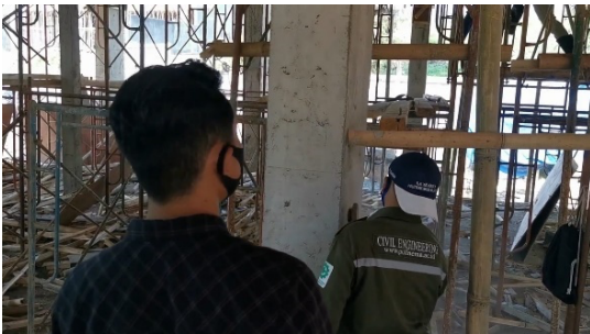
Gambar 3 Pembersihan dengan Kawat Baja pada kolom yang akan di Uji
