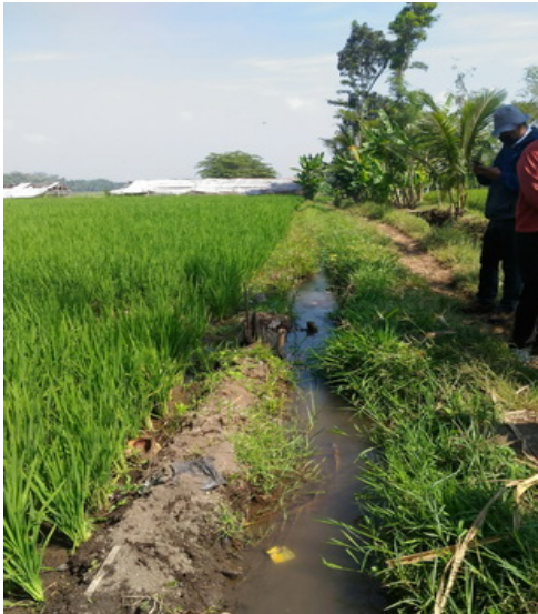
Gambar 3. Kondisi Eksisting Saluran Tanah Km. 0+000 - Km. 0+540
