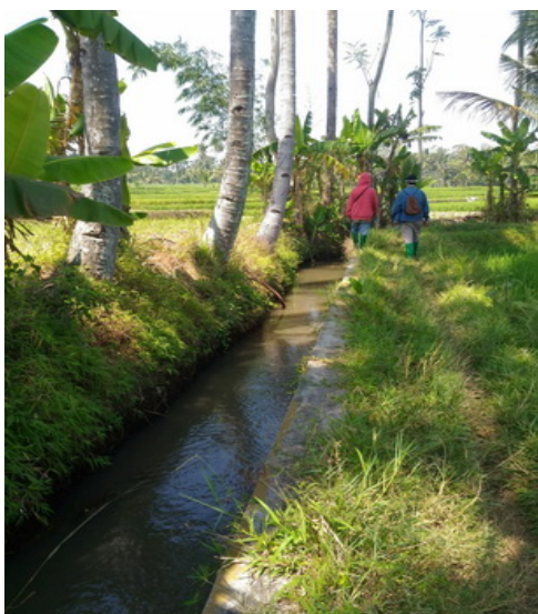
Gambar 4. Kondisi Eksisting Saluran Pasangan Batu Km. 0+000 - Km. 0+300
