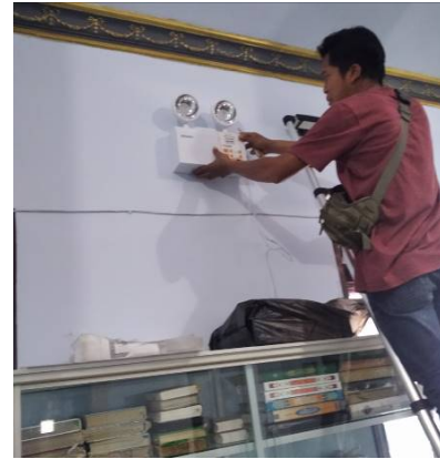
Gambar 6 Pemasangan lampu emergency
