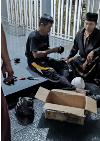
Gambar 4 Pemasangan fitting gantung
