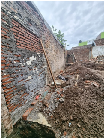
Gambar 2 Proses pekerjaan galian tanah pondasi
