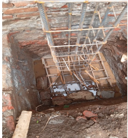
Gambar 3 Proses pemasangan pembesian pondasi
