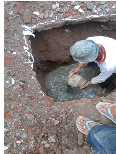
Gambar 4 Proses pekerjaan pengecoran pondasi
