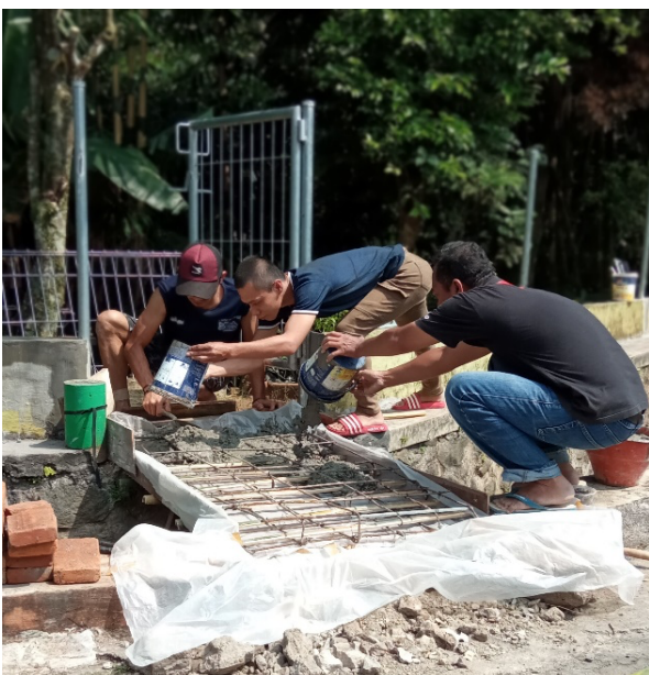
Gambar 6. Pembangunan ulang jembatan
