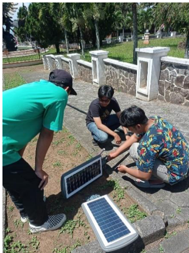
Gambar 6. Perakitan lampu pada tiang
