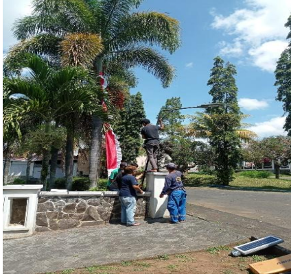
Gambar 8. Proses pemasangan lampu
