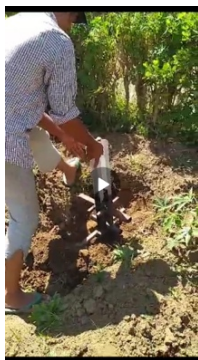
Gambar 4. Pemasangan Pondasi PJU
