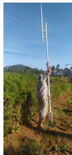
Gambar 3. Pemasangan Tiang PJU
