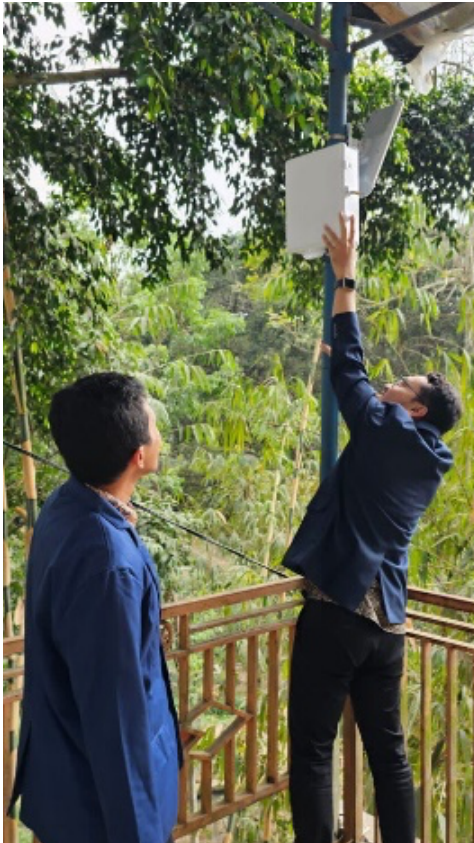
Gambar 5. Proses Pemasangan Perangkat
