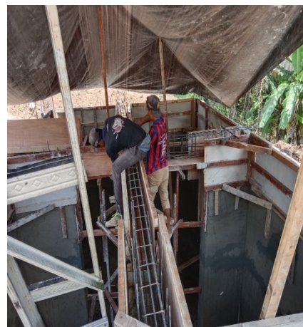
Gambar 1 Pembangunan Toilet di Lingkungan Asrama
