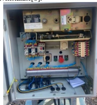
Gambar 3 Grounding PMS (Sumber: Gardu Induk Sutami)
