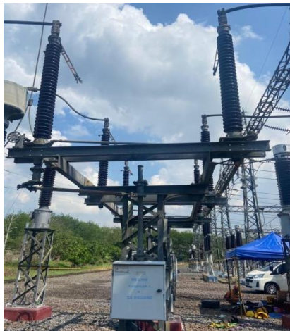
Gambar 1 Pemisah (PMS) (Sumber: Gardu Induk Sutami)
