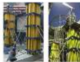
Gambar 3 Bekisting Kolom Sistem Sumber : Google Image
