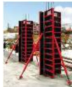
Gambar 2. Bekisting Kolom Semi Sistem Sumber : Google Image
