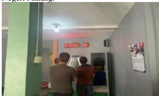
Gambar 1. Pemasangan Moving Sign
