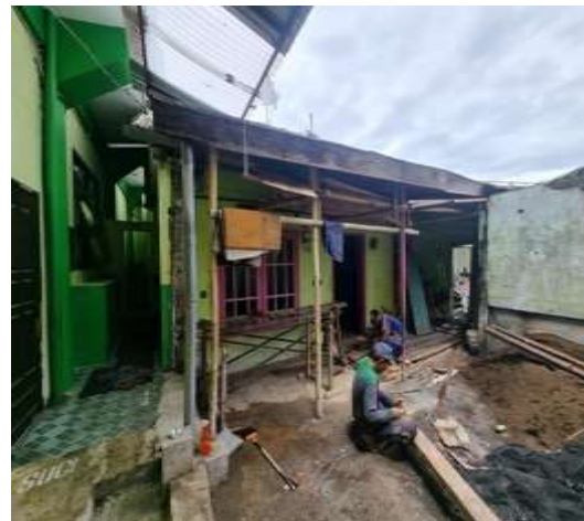
Gambar 1.2 Kondisi eksisting lokasi PPM
