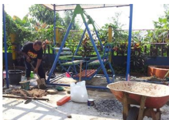
Gambar 15. Pengecoran pondasi kerangka kursi ayunan
