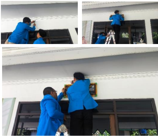
Gambar 4. Proses instalasi perangkat Running Text di lokasi
