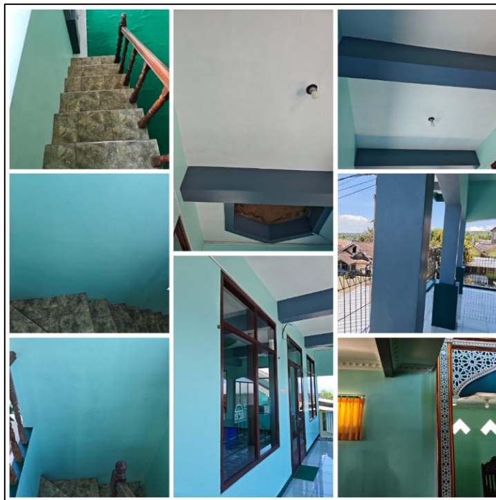
Gambar 6. Kondisi Masjid Setelah Perawatan Masjid
