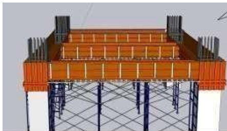
Gambar 10. Pemasangan bottom balok
