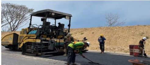
Gambar 6 Asphalt Finisher Sumber: Dokumen Pribadi
