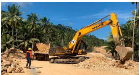
Gambar 1 Excavator Sumber: Dokumen Pribadi
