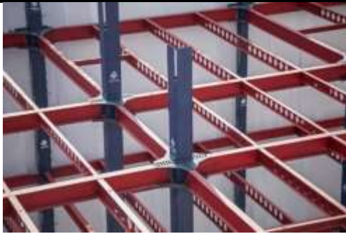
Gambar 1. 1 Elemen Struktur Kolom CFST
