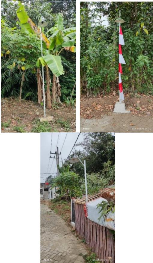
Gambar 5. Hasil Pemasangan Tiang Lampu PJU
