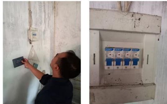
Gambar 2. Pengecekan instalasi listrik mitra
