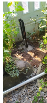
Gambar 5. Pemasangan Pondasi PJU
