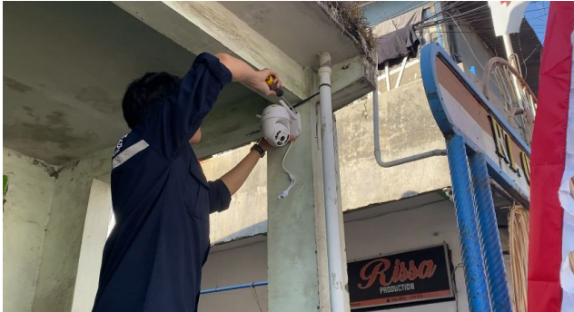
Gambar 3 Pemasangan CCTV di titik komunal
