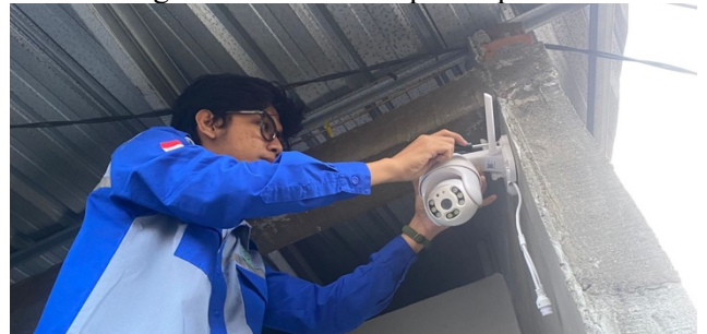
Gambar 2 Pemasangan CCTV di titik persimpangan
