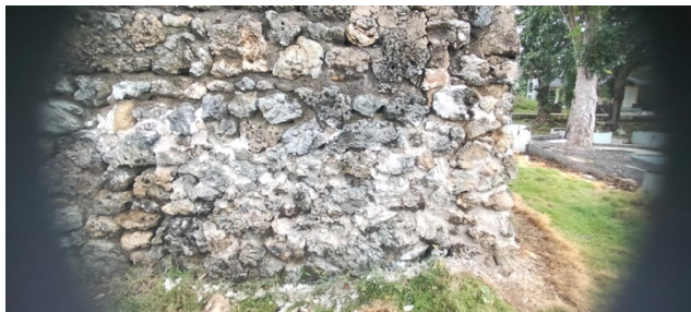
Gambar 11. Hasil perbaikan dinding yang retak
