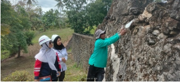
Gambar 9. Tim pengabdian mengawasi perbaikan retakan dinding
