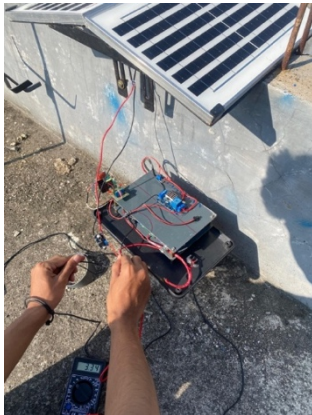
Gambar 9. Pengujian Panel Surya
