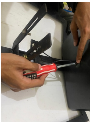
Gambar 6. Pemasangan Panel Surya Pada Braket
